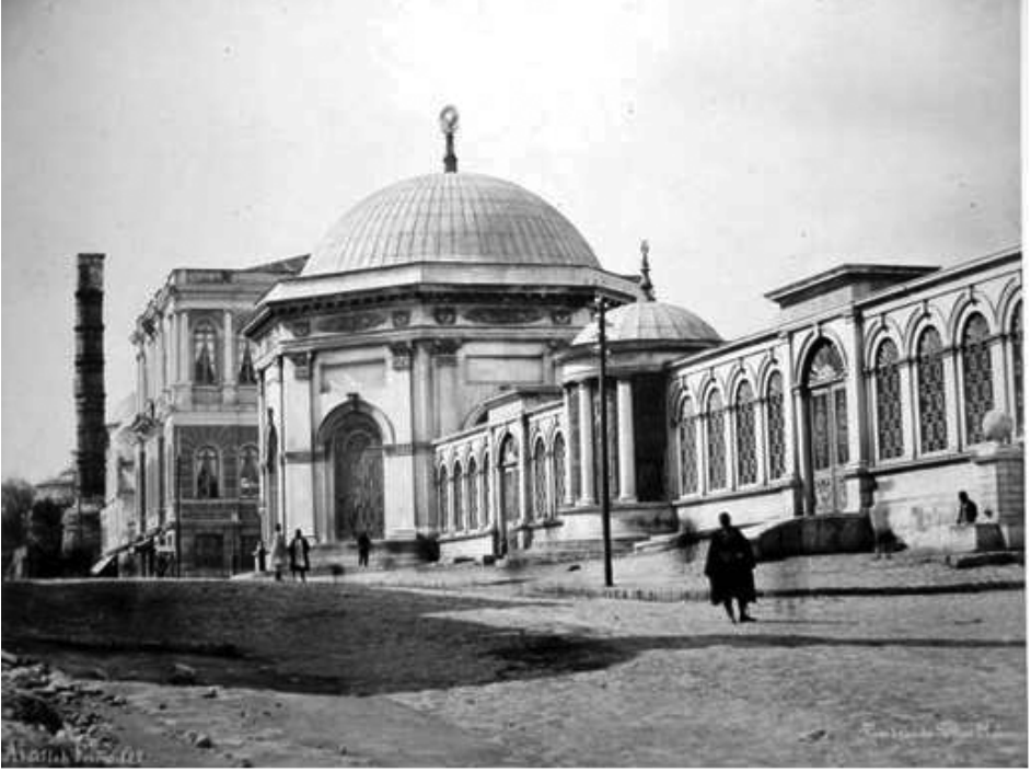
Resim 18- Mekteb-i Mülkiye'nin idadi kısmının eğitim yaptığı, bir dönem Darülfünun, bir dönem Şehremaneti olarak kullanılan Sultan II. Mahmud Han Türbesi'nin yanındaki eski Maarif Nezareti binası (günümüzde Basın Müzesi).
